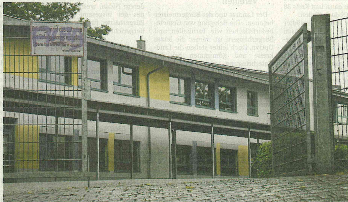
Auch das Georg-Büchner-Gymnasium in Bad Vilbel profitiert von den Zuschüssen des Landes Hessen zum Ausbau der Digitaltechnik.
