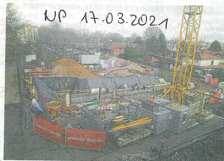
Die Bauarbeiten für die neue Aula am Georg-Büchner-Gymnasium sind in vollem Gange.
